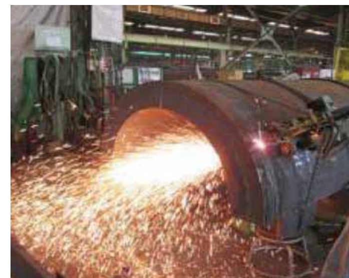
▲円筒形曲げ板の円周溶断状況
