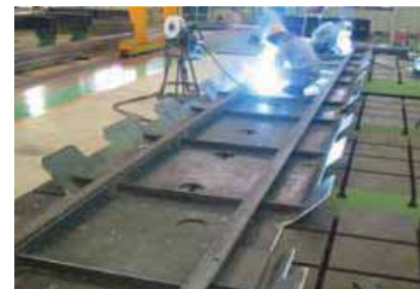
▲プラント用部材の溶接
